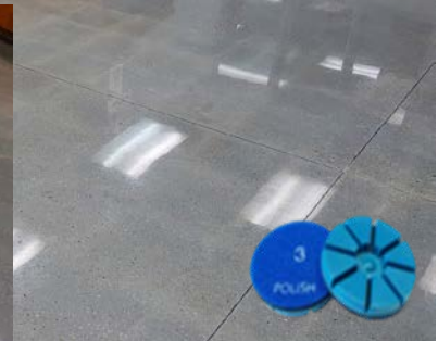
Paso 5: disco "PowerPolish 1 + PowerPolish 2 + PowerPolish 3" 2-4 pasadas para un acabado de Alto Brillo.
