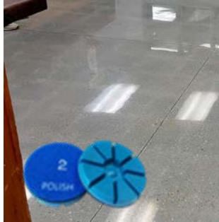
Paso 6: disco "PowerPolish 1 + PowerPolish 2 + PowerPolish 3 + PowerPolish 4" 2-4 pasadas para un acabado de Alto Brillo Mojado.
